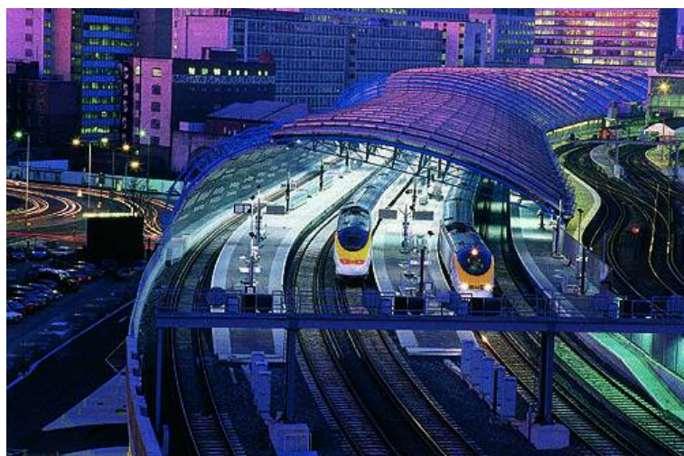
Estación de Waterloo (1993) , London. Nueva terminal de trenes Eurostar. Arquitecto Nicholas Grimshaw.
